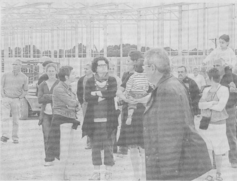
Les premières structures métalliques montées mais pas encore couvertes.
